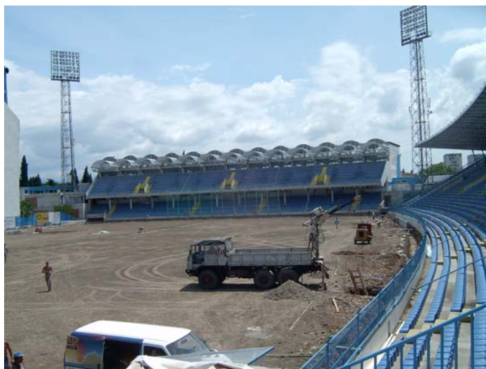
Slika 1 – Gradski stadionu Podgorici u fazi izgradnje
